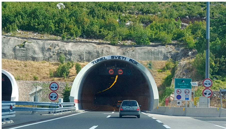
Figure 9. Sveti Rok road tunnel.
